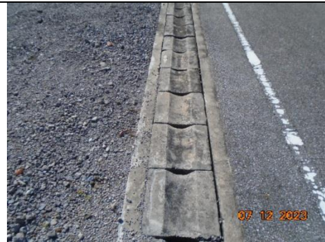
ภาพที่ 2-12 ระบบระบายน้ำฝนภายในโครงการ
