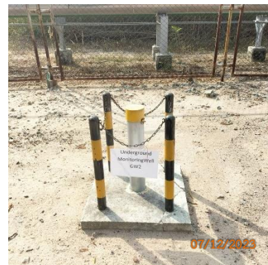
ภาพที่ 2-24 บ่อสังเกตการณ์ (Monitoring Well)
